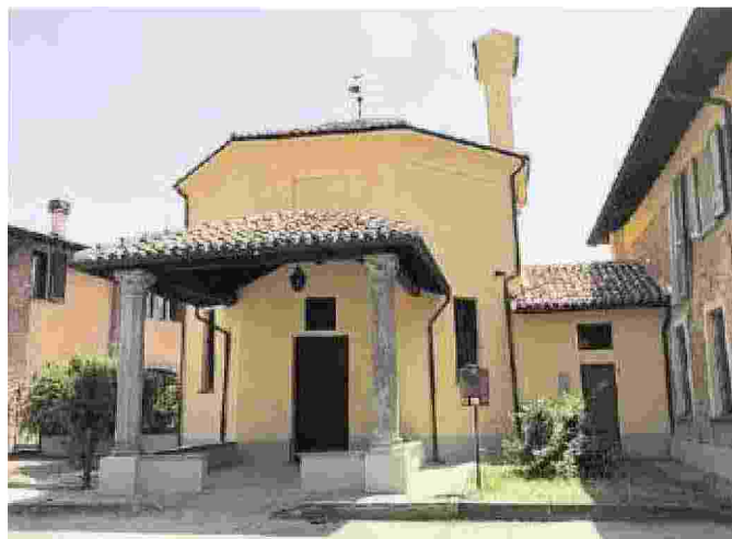
La chiesetta di Sant'Eustachio rimessa a nuovo dai restauri
